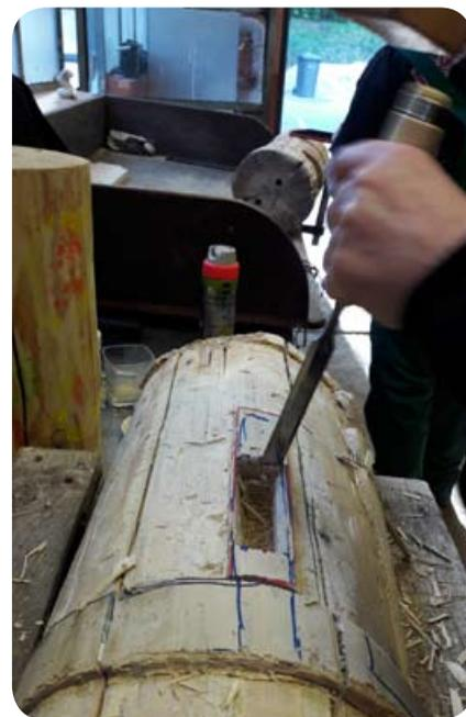
Abb. 6: Sämtliche Handwerksarbeiten werden mit Werkzeugen ohne Elektroantrieb durchgeführt.
